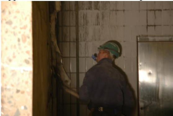
Figur 9. Rivning på Carlsbergs bryggerier.
