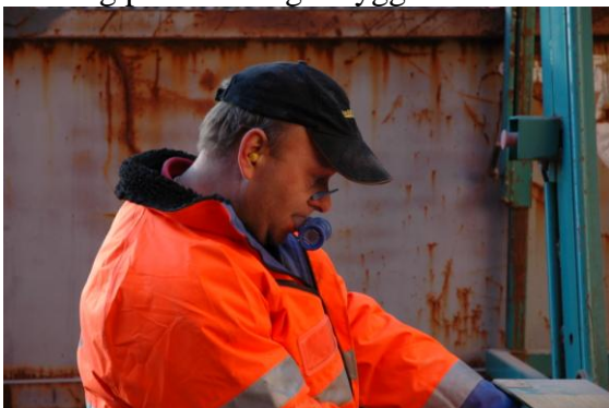
Figur 10. Rivningsarbete, Carlsbergs bryggerier.
